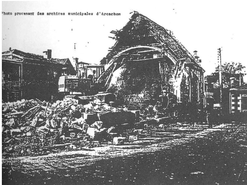
Demolition du Temple de la Ville d'Été d'Arcachon en 1977
